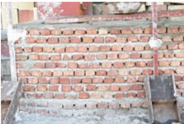
تصویر ۳- قبل از اجرای نماسازی با سنگ باید تراز کردن سطح موردنظر انجام شود.
