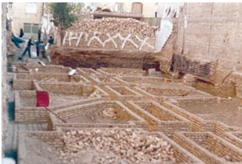
تصویر ۵ - قالب بندی آجری بی ساختمان
