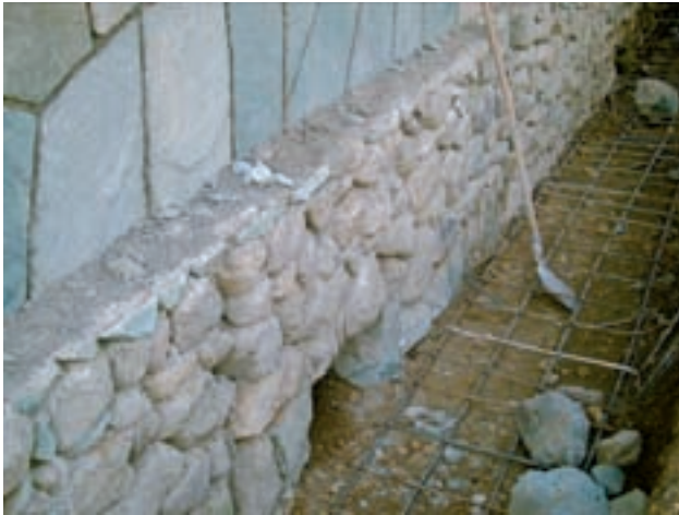
تصویر ۱- پی و دیوار سنگی
