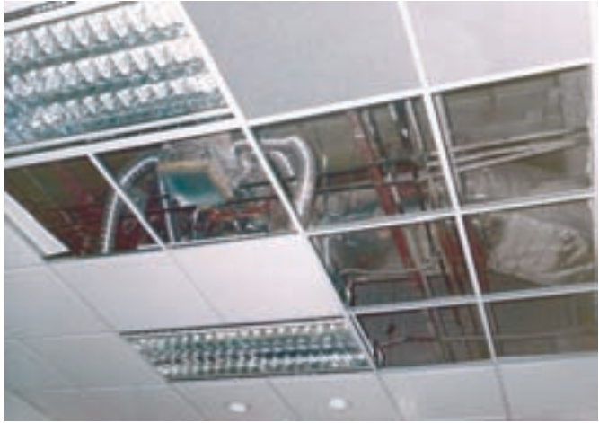
تصویر ۲۰ - زیر سازی سقف کاذب
