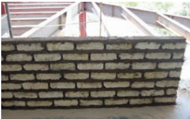
تصویر ۱۴ - دیوار نیم آجره (۱۱ سانتی‌متری)
